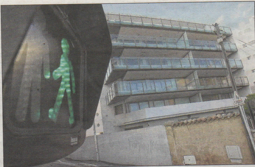
Cet immeuble, situé à l'angle des rues Esprit-Violet et Ricord-Laty, sera-t-il démolit ? (Photo A.B-J.)
