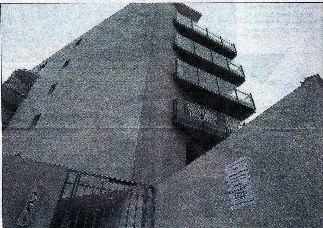
Le tribunal administratif vient d'annuler le permis de construire accordé le 9 décembre 2002 au promoteur qui achevait les travaux de cette résidence de onze appartements à l'angle des rues Ricard-Laty et Esprit-Violet. (Photo A. B.-J.)
