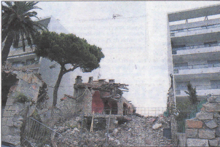
La villa « Canare », située au 109 de l'avenue de Lérins et au 152 du boulevard Gazagnaire, datait à peu près des années vingt du siècle dernier. Depuis juillet, la bâtisse reste à moitié détruite à cause d'une suspension du permis de démolir.
